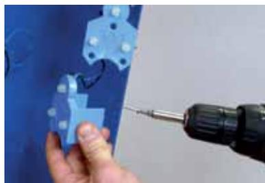
Dans le cas d'une lettre creuse, visser le module sur le chant de la lettre grâce aux deux languettes disposées de part et d'autre de la coque.
